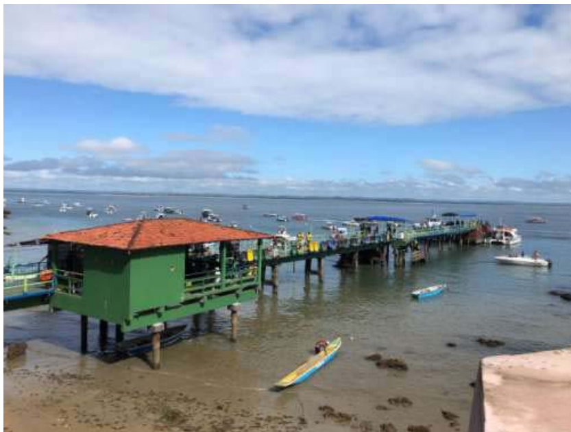
Figura 1 - Vista geral do Píer de Atracação e Passarela de Acesso.
